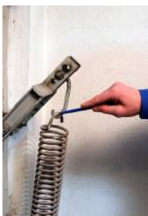
Billede 5: For vippeporte af ældre dato kan der være risiko for at fjedrene springer. Her ses en gammel vippeport, der ikke lever op til EUs standard for sikkerhed. Der er risiko for at fjedren springer af og porten falder ned.
