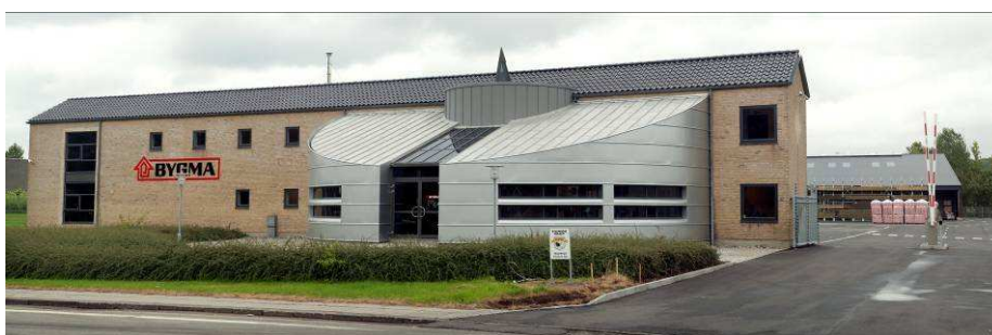
Billede 4: Fremtidens trælast har fokus på effektiv selvbetjening. I den nye Bygma trælast i Vejle, har man indrettet varehallen så af- og pålæsning sker let og så kødannelsen ved varehallens ind- og udkørsel er reduceret markant.
