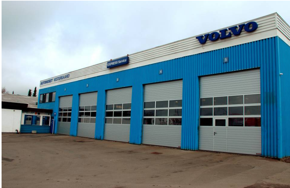
Billede 2: Autohuset Vestergaard i Flegmade, Vejle monterede i samarbejde med Hörmann store ledhejseporte af typen SPU 40, som er stålporte med høj isolering. Portbladet er 42 mm tykt og indeholder 100 % freon-frit polyuretanskum. Tilsammen giver det porten en robusthed og en varmeisoleringsværdi, der kan aflæses på bundlinjen.
